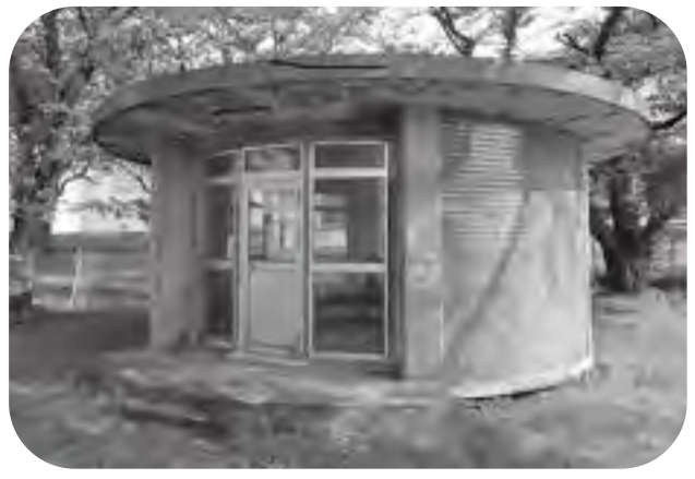
改築が計画されている大楯浄水場第2水源建屋
