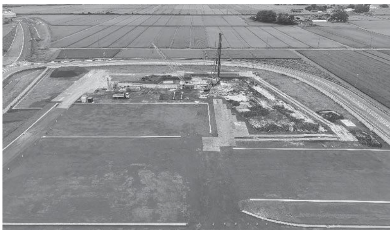
工事状況全景（R8.7撮影）
