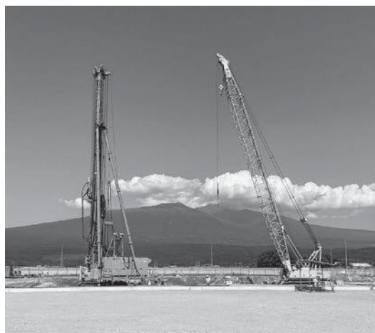
掘削機とクレーンによる杭工事
