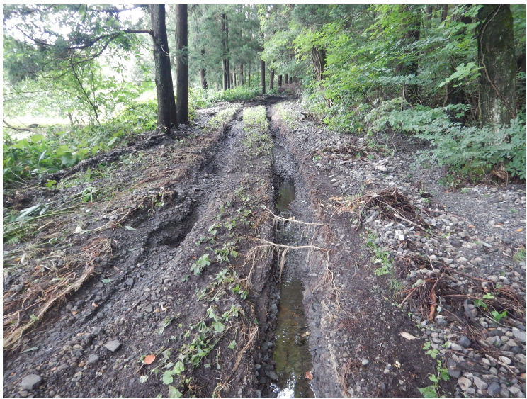
No.1 村上線 土砂流出 写真下側から
