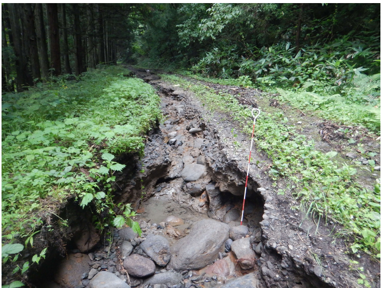
No.3 若林線 砂利流出 写真下側から
