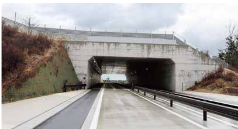
このトンネルの上にクロマツを植林しています
