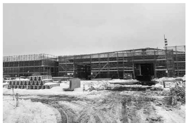
工事現場全景【南側】 撮影日／12月21日
