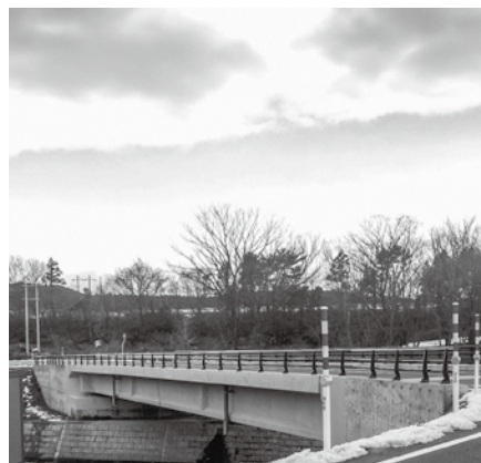
完成した広畑橋
