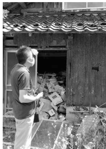
現地におもむき空き家の調査
