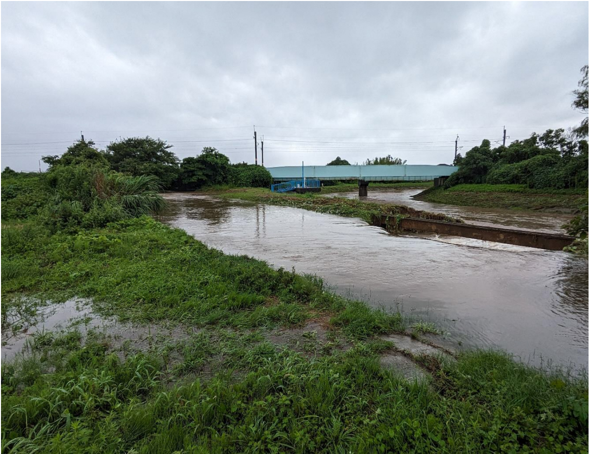
② 高瀬川 決壊（一部） 下野沢地内
