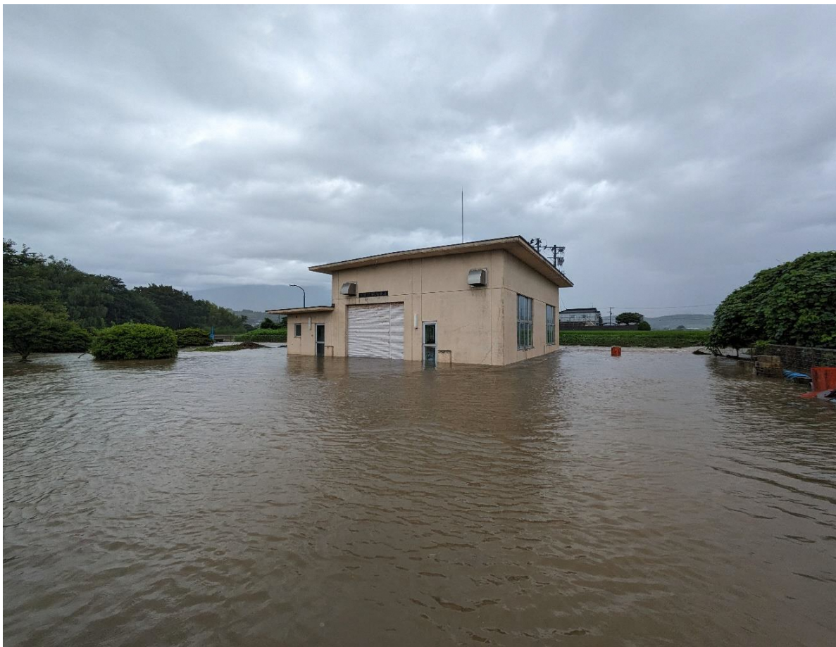
② 下野沢揚水機場 冠水
