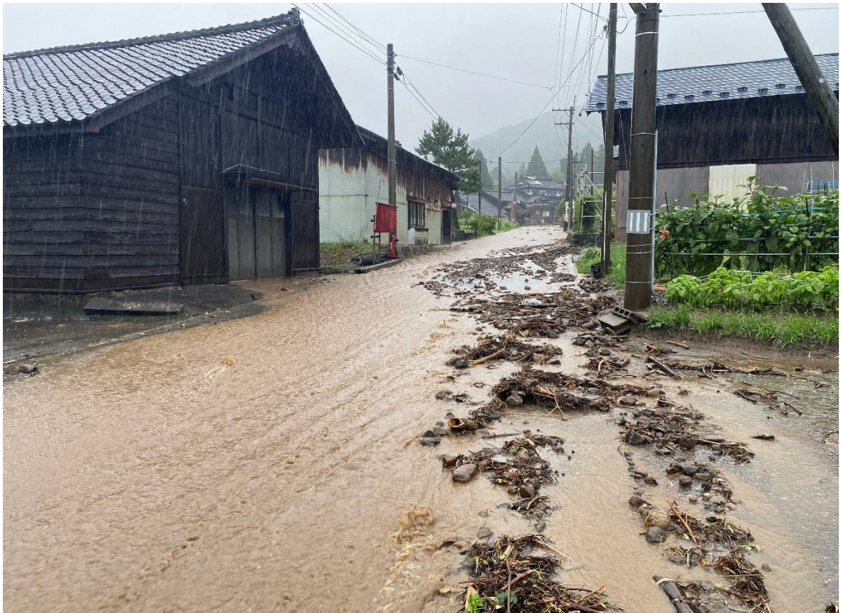
④杉沢土砂崩れ
