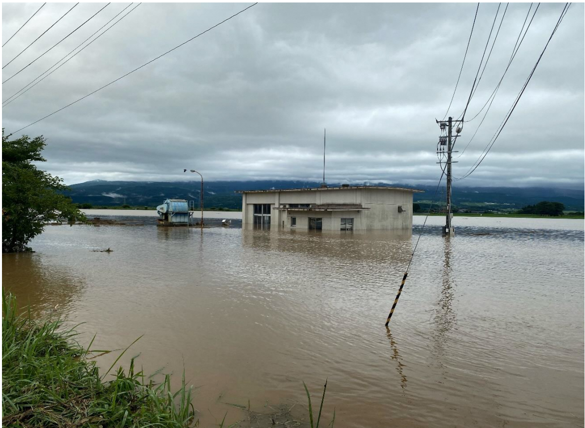
①西通川揚水機場 冠水
