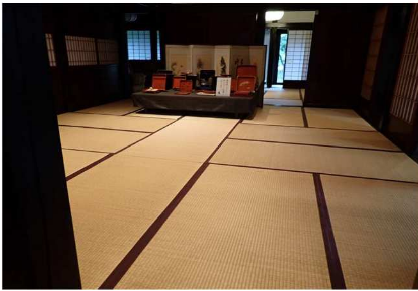
語りべの館 内部 畳部分は一段高く、浸水を免れた。
