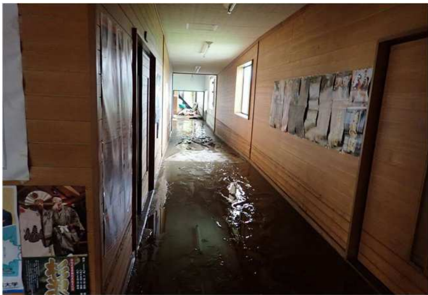
杉沢比山伝承館内部
