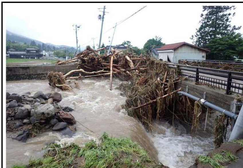
杉沢地内熊野橋
