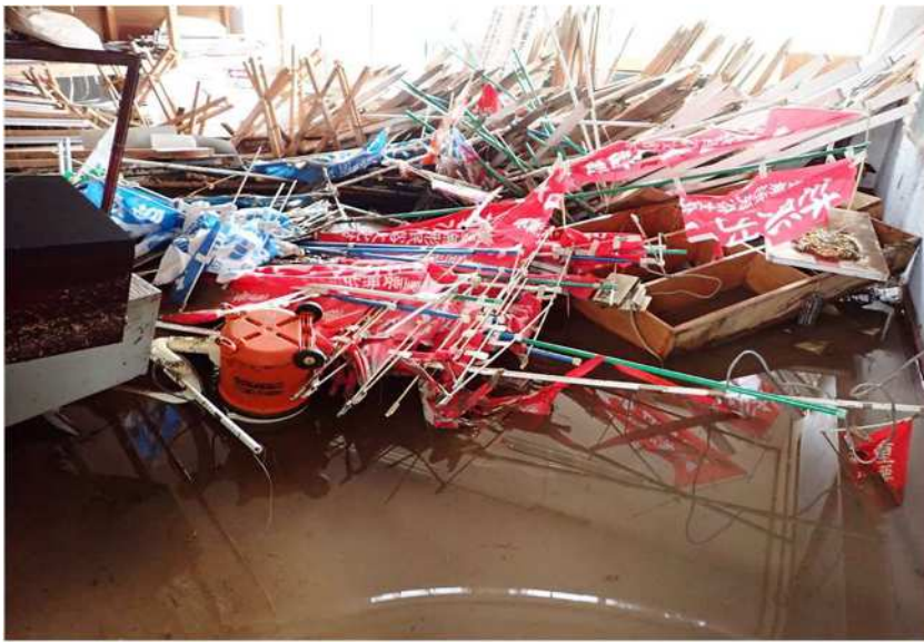
杉沢比山伝承館内部
