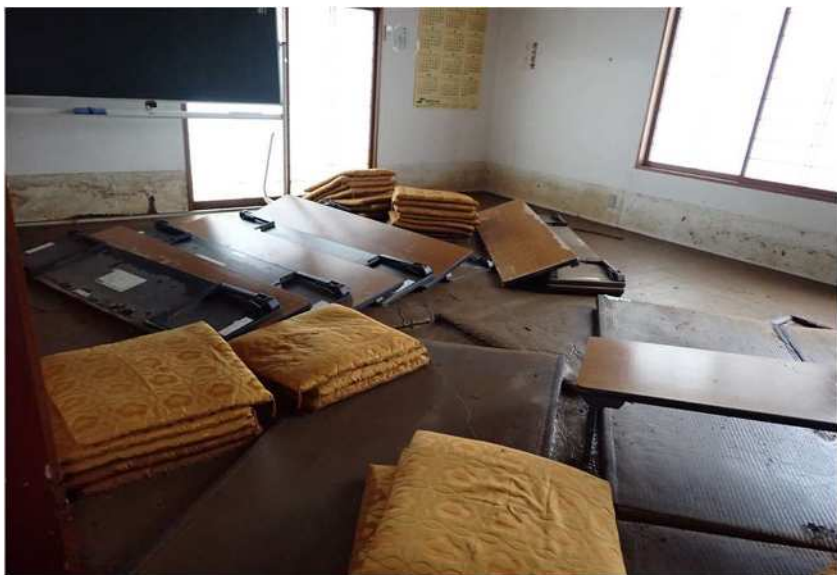
杉沢比山伝承館内部
