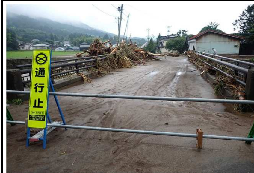
杉沢地内熊野橋
