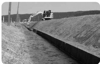
排水路法面の整形作業
