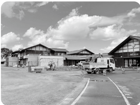
移転工事が始まった旧蕨岡小
