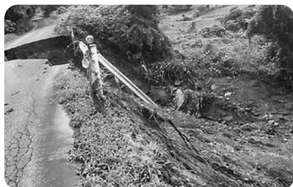
復旧完了に向けて
