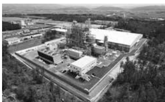
バイオマス発電所全景
