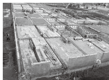
西側エネルギー棟仮設現場の上から撮影（7月22日現在）
