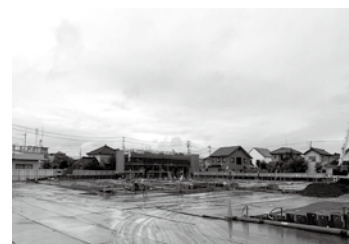
①工事状況全景（南側より）
