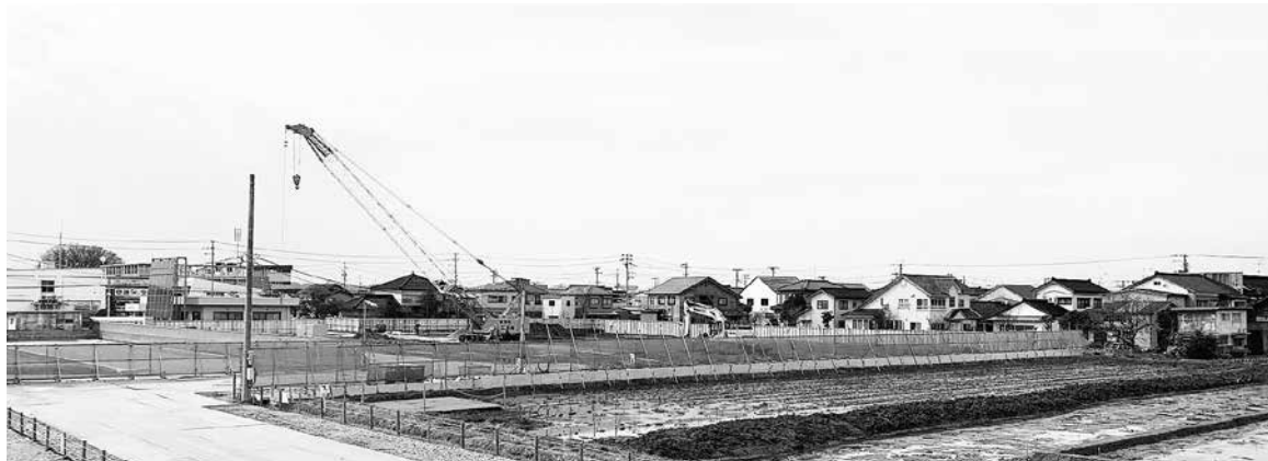
工事状況全景（南東側から R2.4.7撮影）
