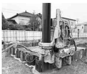
基礎工事の土留めとなる 矢板の仮設工事
