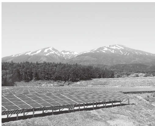
吉出の「庄内・遊佐太陽光発電所」
