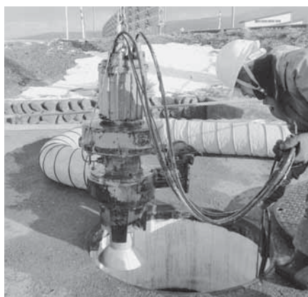
マンホールに詰まったモップの除去作業
