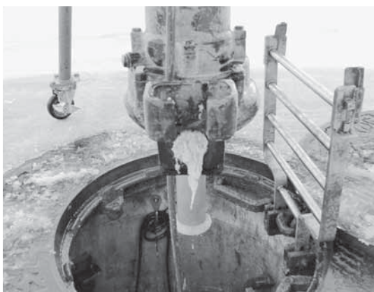
マンホールに詰まったモップの除去作業
