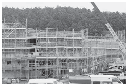
工事中の吹浦地区防災センター
