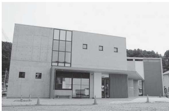
新しく完成した吹浦地区防災センター
