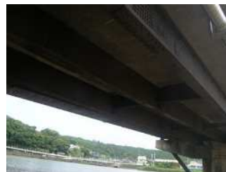
▲西浜橋 (橋長 142.14m) 耐候性鋼材, 塩害地域
