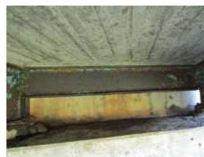
▲横桁の腐食
