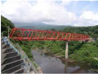
▲月光川大橋 (橋長 135.00m) 孤立橋梁, 特殊橋梁
