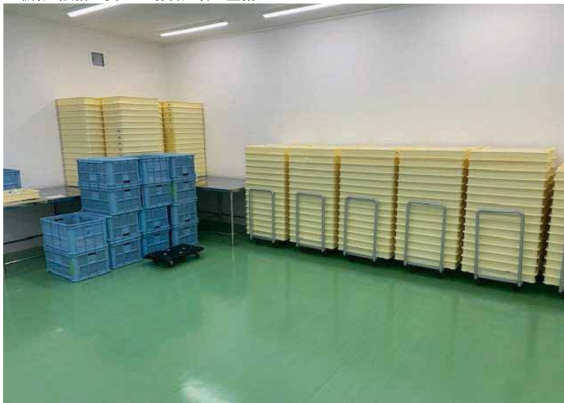
梱包室(天井(照明)、壁、床、水道、電源設備等の改修) ※機械・設備は貸加工場利用者が整備
