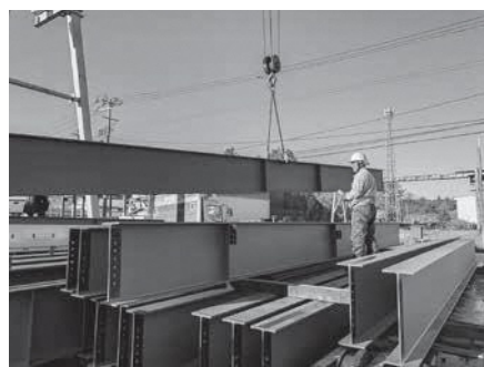
クレーン作業中
