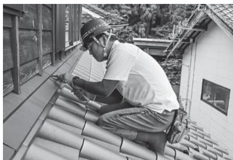
瓦工事の様子
