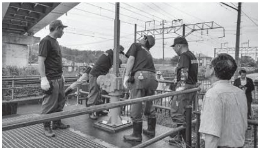
水門点検の様子
