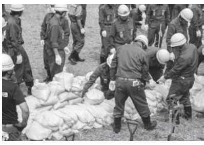
積み土のう工法
