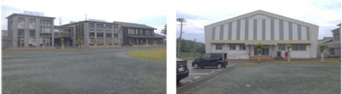
学校外観（藤崎小学校）
