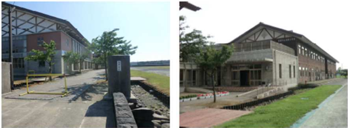
学校外観（高瀬小学校）
