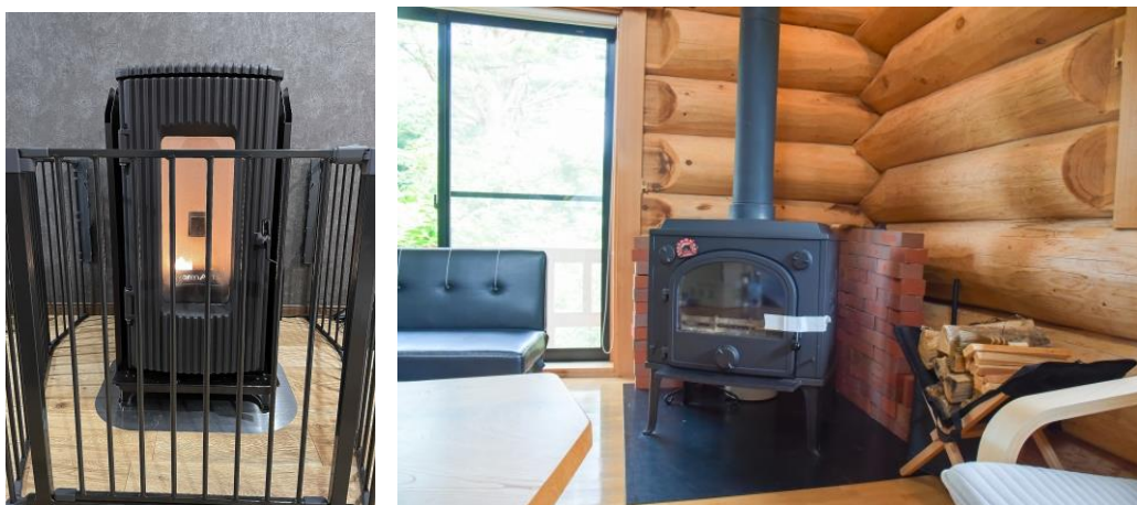
ペレットストーブ（左）と薪ストーブ（右）の設置例
