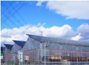
発電施設の外観
