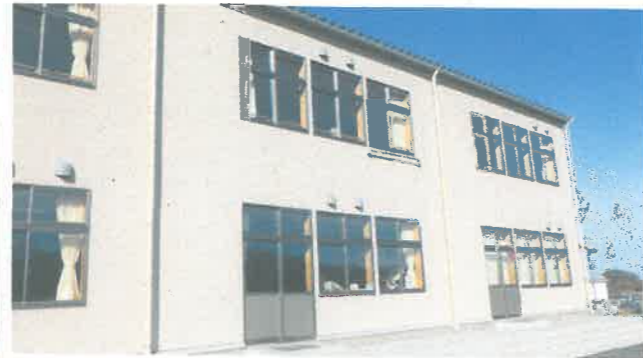
プラスルーム外観
