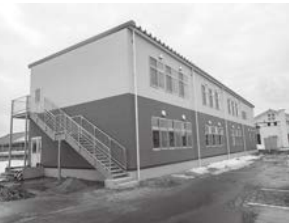
遊佐小学校敷地内に増築された校舎
