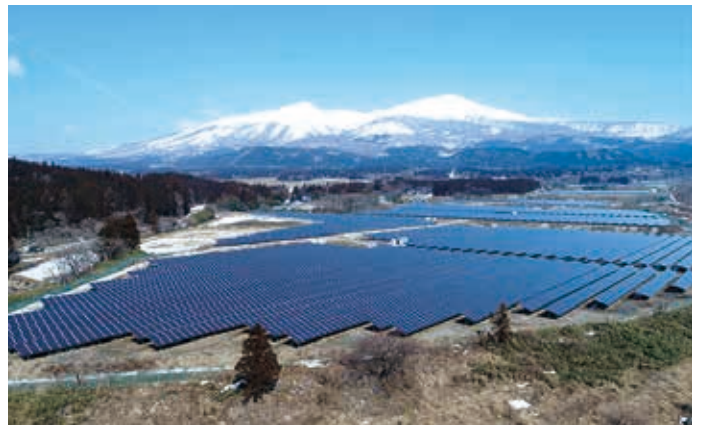
庄内遊佐太陽光発電所
