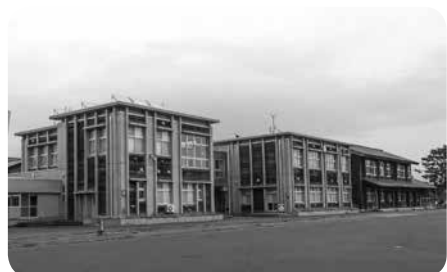
修正案が出された餅加工施設改修 (旧藤崎小)
